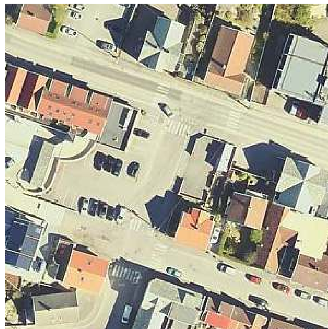
Innkjørsel til Skudeneshavn via Postvegen, T-krysset i møte med Selvåg.
